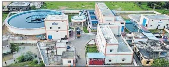
पाइप पेयजल योजना का ट्रीटमेंट प्लांट। उम्मीद है कि इस साल यह मूर्तरूप ले लेगा।
